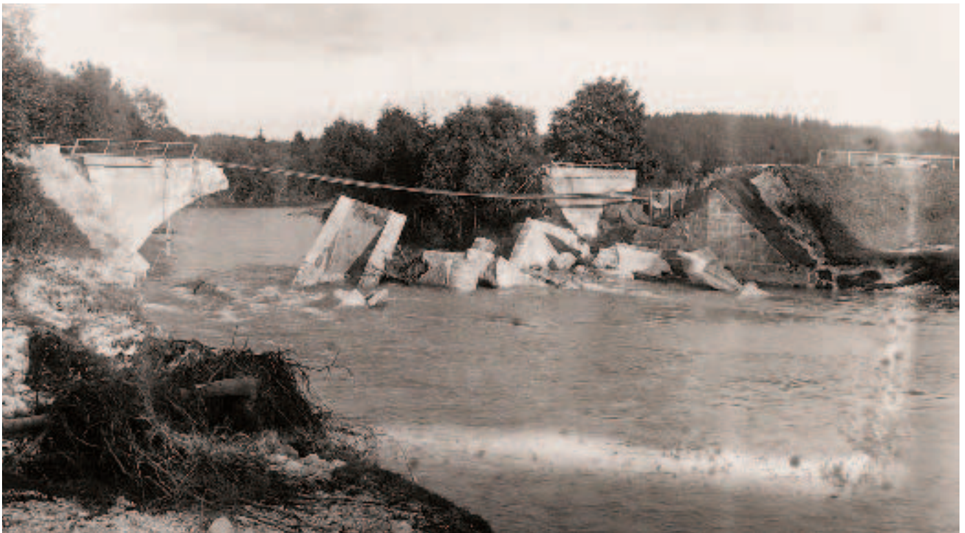
Reste der Traunbrücke bei Hörpolting nach dem Hochwasser im September 1899
