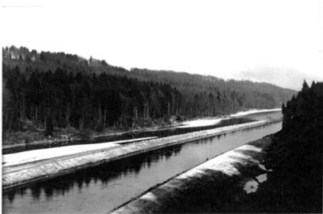
Trennungsdamm zwischen Isar und UW-Kanal bei Fkm 164.6 - 165.0, 14.11.28
