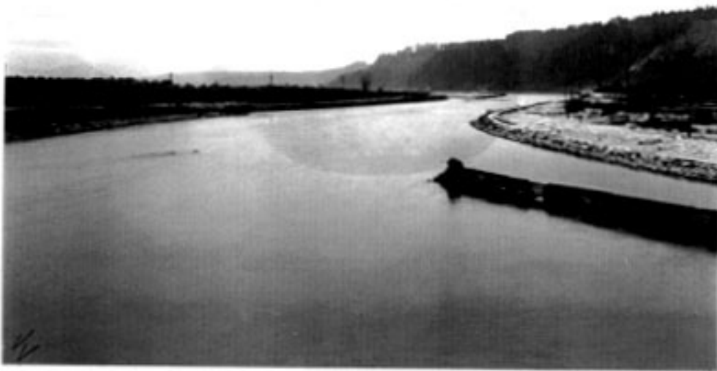
Vom Ickinger Wehr (Fkm 173.95) flussaufwärts, 14.11.28
