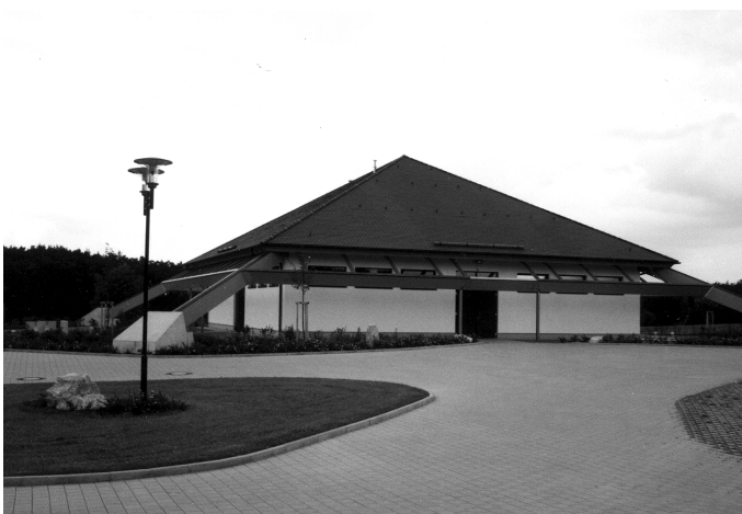
Abb. Pumpwerk und Aufbereitungsanlage Haslach
