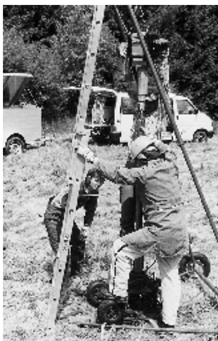
Abb. Entnahme von Bodenproben mit der leichten Rammsonde
