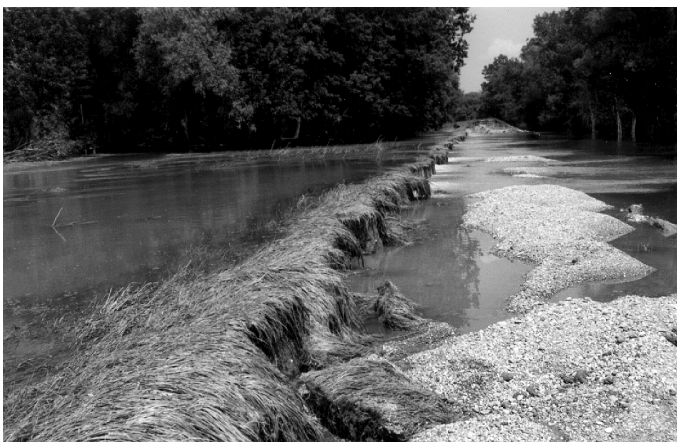
Abb. 8 Deichbruchstelle in Neustadt a. d. Donau nach Ablauf des Hochwassers
