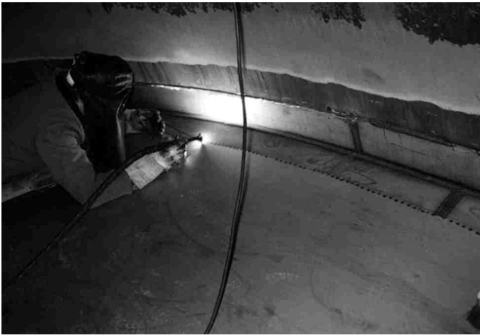
Abb. Einschweißen eines Doppelbodens (Staroba AG, Schweiz)
