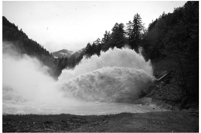
Abb. 6 Ein ungewöhnliches Schauspiel ereignete sich am Sylvensteinspeicher, als bedingt durch einen vorübergehenden Bauzustand die neue Hochwasserentlastungsanlage ansprang
