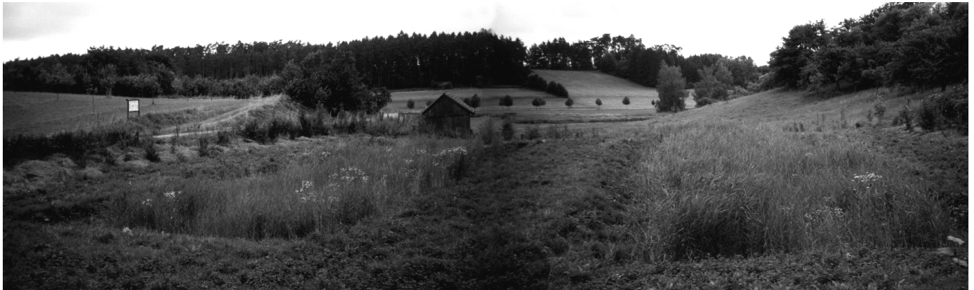
Abb. Pflanzenkläranlage Steinerskirchen
