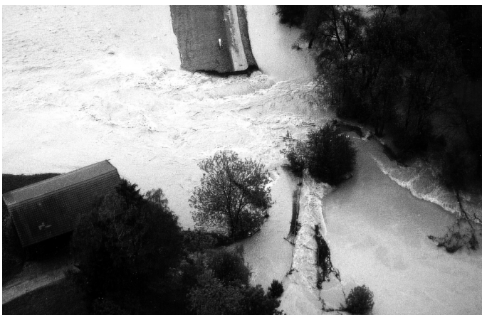
Abb. 7 Die Abflüsse lagen vielfach über dem Ausbaugrad der Deiche: Deichbruch bei Flecken im Allgäu am 22.05.1999
