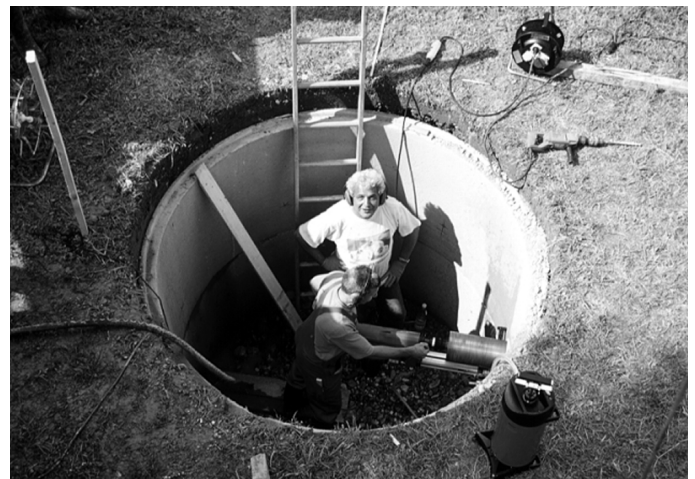
Abb. Bau eines Schachtes zur Sickerwassererfassung auf dem Versuchsgelände in Wielenbach
