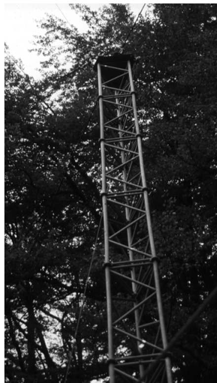
Abb. Fingerstütze, der Seilsattel ist hier auf der Stützenkopfplatte montiert
