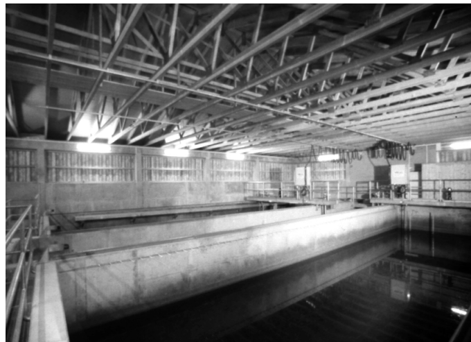
Abb. Flachbettfilter Kläranlage Mittenwald
