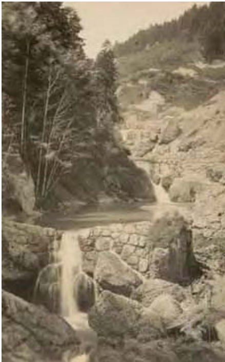
Blick ins Steigbachtal mit den 1874 „neu“ errichteten Wildbachverbauungsarbeiten.
