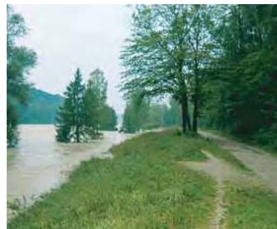
Der im Rahmen des „Isarplanes“ erhöhte und verstärkte Deich südlich des Marienklausestegs. Vor und während des Augusthochwassers 2005.
