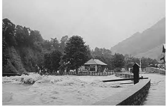
Die zerstörte Hundsreitbrücke in Marktschellenberg beim Hochwasser 1959 - die Pegelanlage steht noch.
