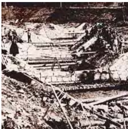
Bau der Konsolidierungssperren am Griesenbach nach dem Hochwasser im Jahr 1898.
