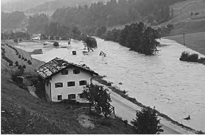
Die Berchtesgadener Ache 1959 unterhalb von Berchtesgaden – ein Lkw sucht die Straße im Hochwasser.
