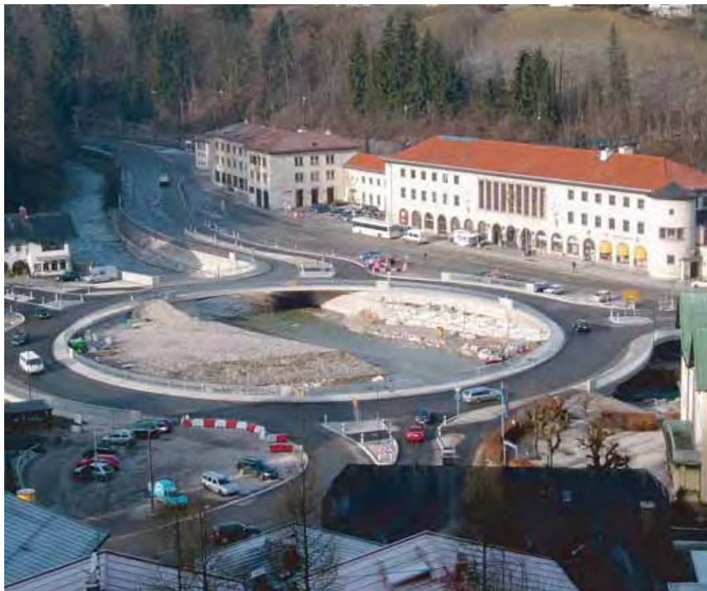
Die neue hochwassersichere Verkehrsführung am Zusammenfluss von Königsseer und Ramsauer Ache.
