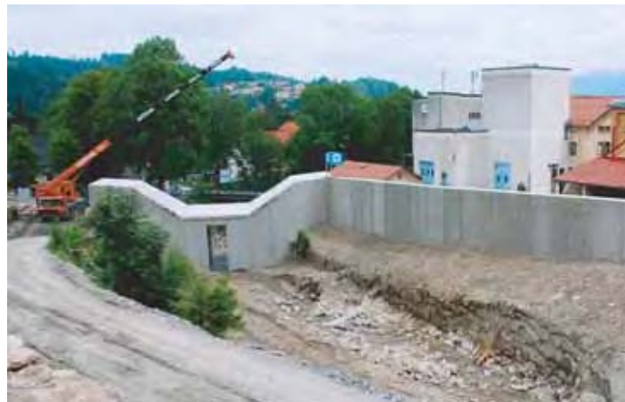
Massive Schutzmaßnahmen unterhalb der noch aktiven Rutschung.
