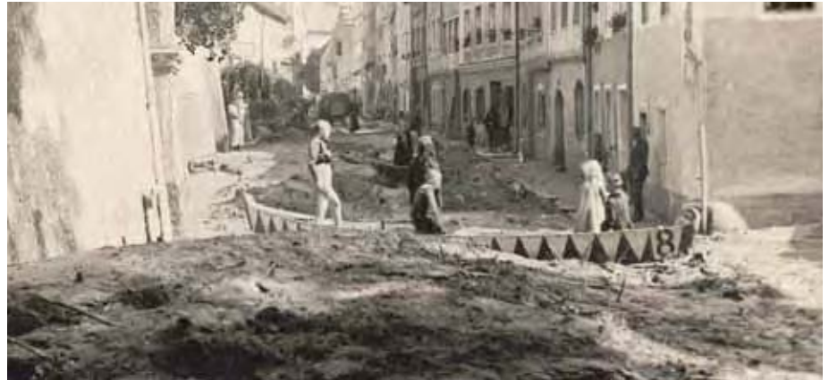
Schlammablagerung nach Hochwasser in der Altstadt von Burghausen 1899.
