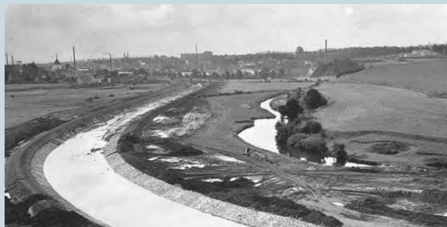
Saaleregulierung in der Stadt Hof („Saale-Durchstich“) vor Einlass des Wassers 1957.
