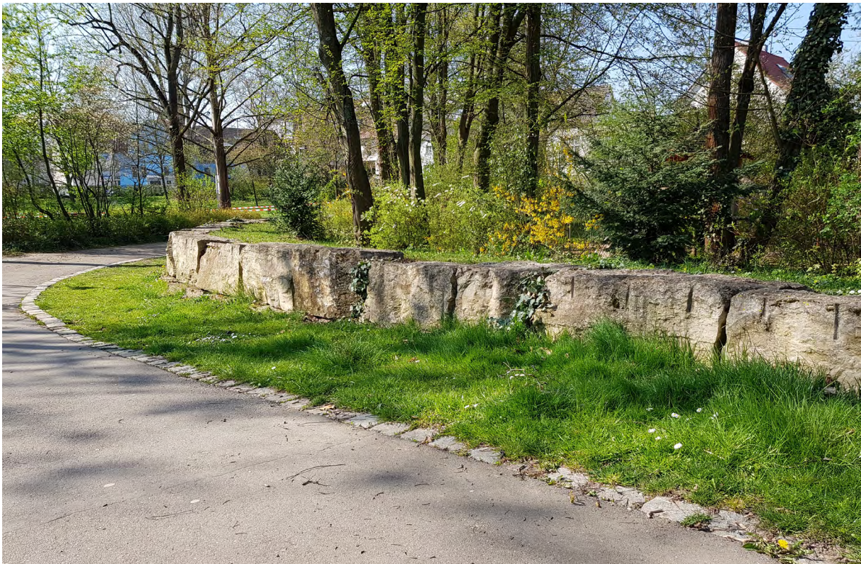
Abbildung 1: Steinmauer Kita Hohenstufenstraße.
