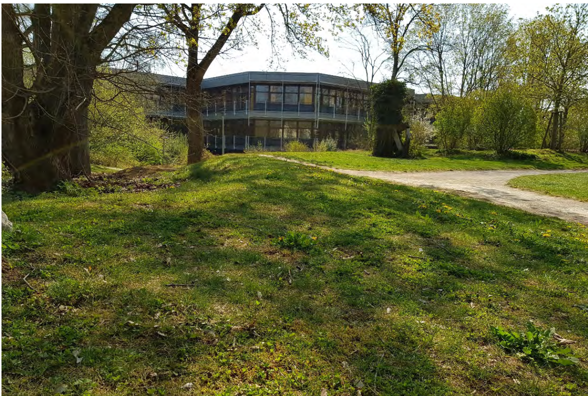
Abbildung 2: Erdschutzwall Schulzentrum Glemsaue.
