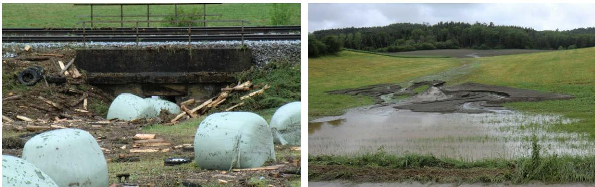
Abb. 5: Durch Oberflächenabfluss mobilisierte Gegenstände verklauen den Durchlass unter einer Bahnlinie (links). Aus einem Acker erodierte Feinstoffe werden in tieferliegenden Bereichen abgelagert (rechts).
