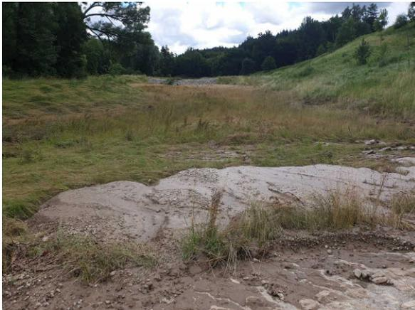
Abb. 30: Im Becken 2 „entlang Staatsstraße“ zurück gehaltenes Bodenmaterial nach dem Starkregenereignis. Das Becken selbst ist bereits leergelaufen.
