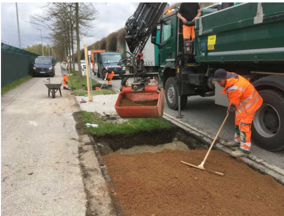
Abb. 10: Einbau der bewachsenen Bodenzone einer Versickerungsmulde.
