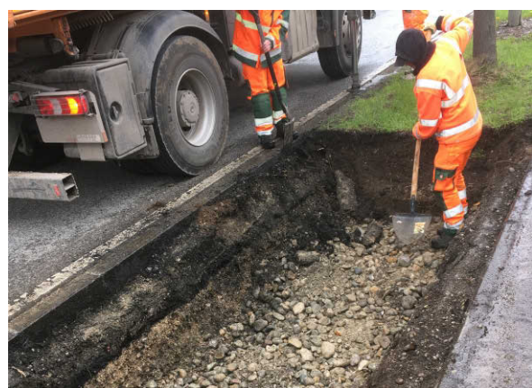
Abb. 9: Modellierung des Unterbodens für die geplante Versickerungsmulde
