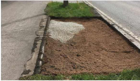
Abb. 11: Aufbringung der mineralischen Mulchschicht.
