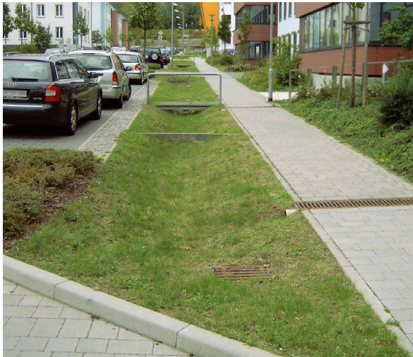
Abb. 1: Versickerungsmulde mit konventioneller Rasenbegrünung
