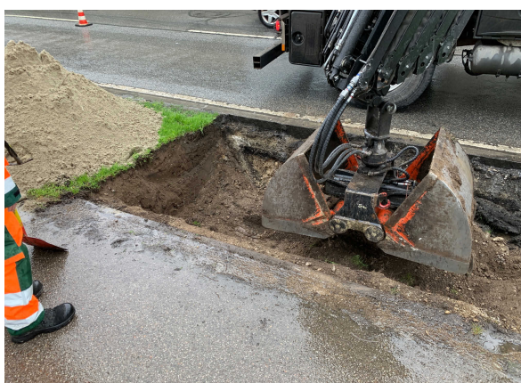
Abb. 8: Aushub für eine straßenbegleitende Versickerungsmulde (im Bestand)
