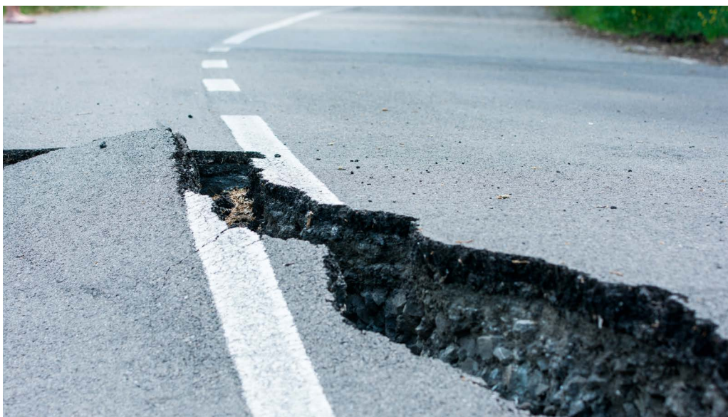
Abb. 4: Straßeneinbruch im öffentlichen Verkehrsraum
