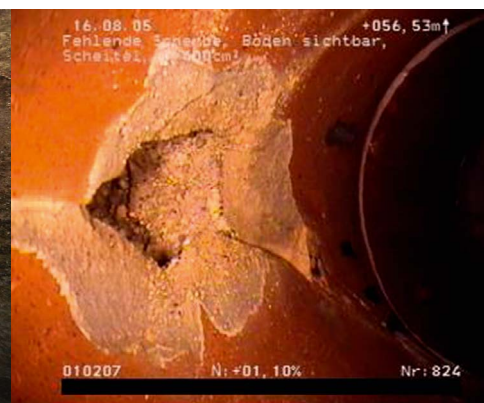
Abb. 15 (links): Undichte Rohrverbindung Abb. 16 (Mitte): Verstopfung durch Wurzeleinwuchs Abb. 17 (rechts): Scherbenbruch
