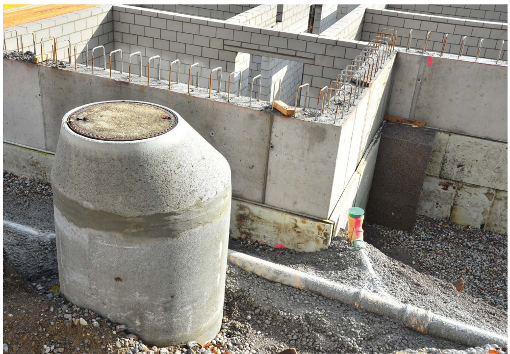
Abb. 1: Baustelle mit Grundstücksentwässerungsanlage
