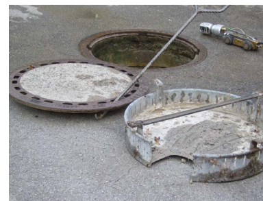
Abb. 21: Gut erreichbarer Revisionschacht (mit Kanal-kamera)
