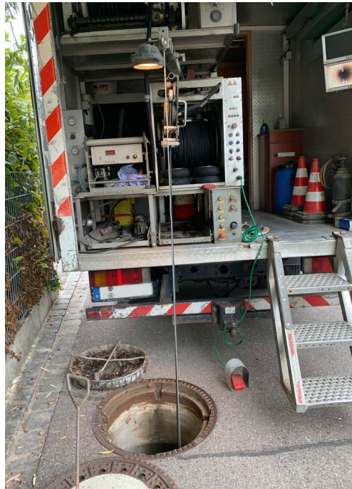
Abb. 7 (links): Optische Inspektion mit einer Kanal-kamera
