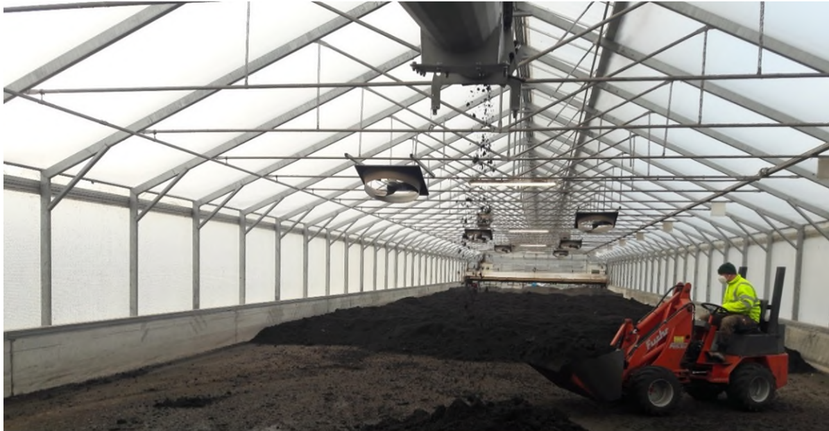
Abb. 11: Solare Klärschlamm-trocknung in einer Halle
