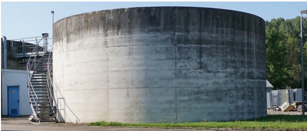
Abb. 5: Schlammstapelbehälter zur Zwischenspeicherung und ersten Eindickung von anfallendem Klärschlamm
