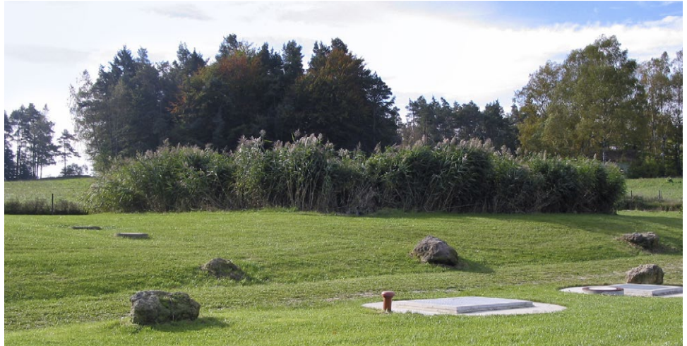
Abb. 2.8: Langjährig betriebener bepflanzter Filter („Pflanzenkläranlage“)
