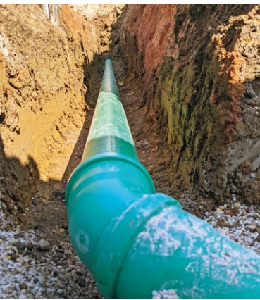
Abb. 6: Bau einer Grundstücksentwässerungsleitung
