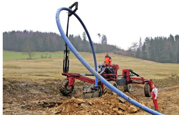
Abb. 19: Einpflügen einer Verbundleitung
