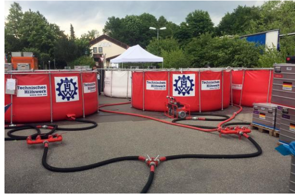
Abb. 6: Trinkwasseraufbereitung des THW beim Freibad in Simbach am Inn
