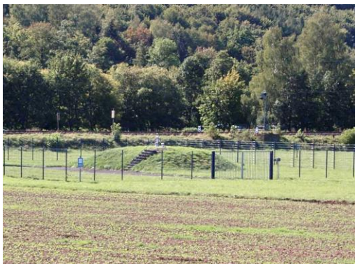
Abb. 78: Brunnen mit Sicherung gegen Hochwasser
