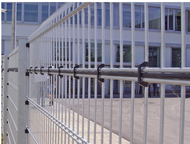
Abb. 84: Zaun mit elektronischer Überwachung
