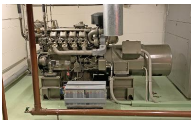
Abb. 69: Stationäre Dieselnetersatzanlage
