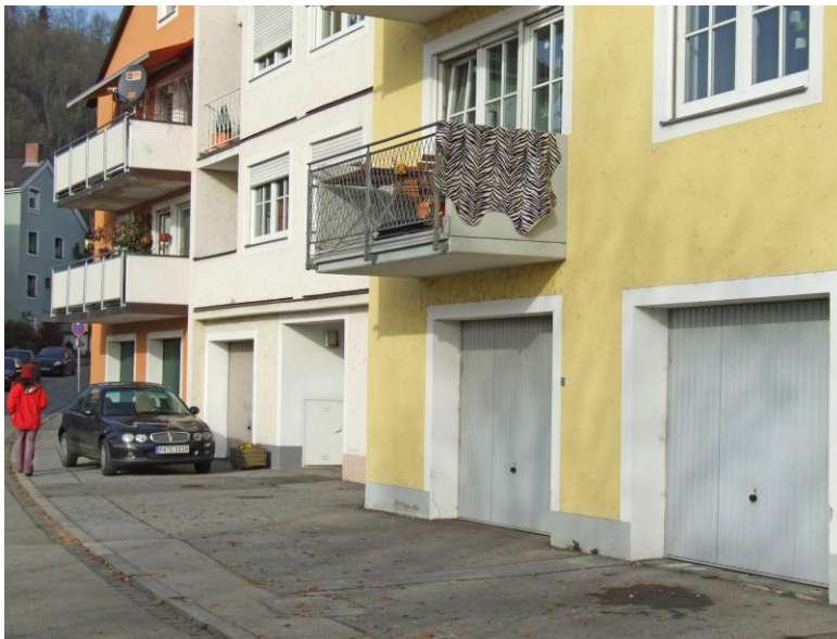
Abb. 80: Untergeordnete Nutzung im Erdgeschoss (überflutungsgefährdeter Bereich)
