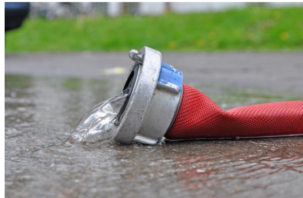
Abb. 13: Feuerlöschschlauch ohne Wasser
