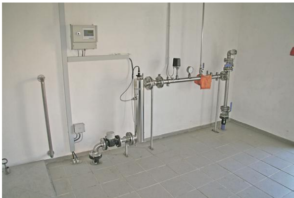
Abb. 18: Desinfektionsanlage
