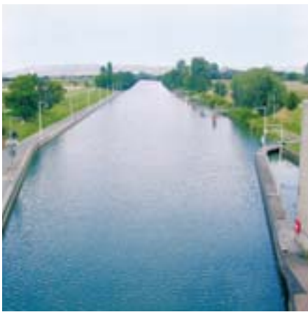
▲ Die großen Staustufen des Lech, wie die Staustufe 21 bei Landsberg/Lech, sind vorläufig als erheblich veränderte Fließgewässerstrecken eingestuft (Bild oben). Der Main-Donau-Kanal bei Hausen im Landkreis Forchheim (Bild unten).
