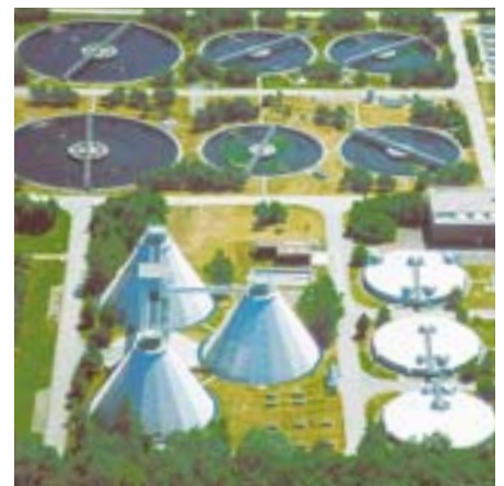
▲ Die größten kommunalen Kläranlagen stehen in München: Kläranlagen München I und II mit zusammen knapp 3 Mio. Einwohnerwerten.
