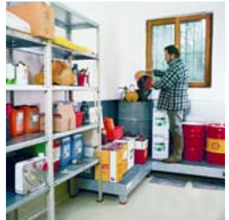
▲ Lagerraum für Wasser gefährdende Stoffe mit Auffangbehältern und Bodenabdichtung.
