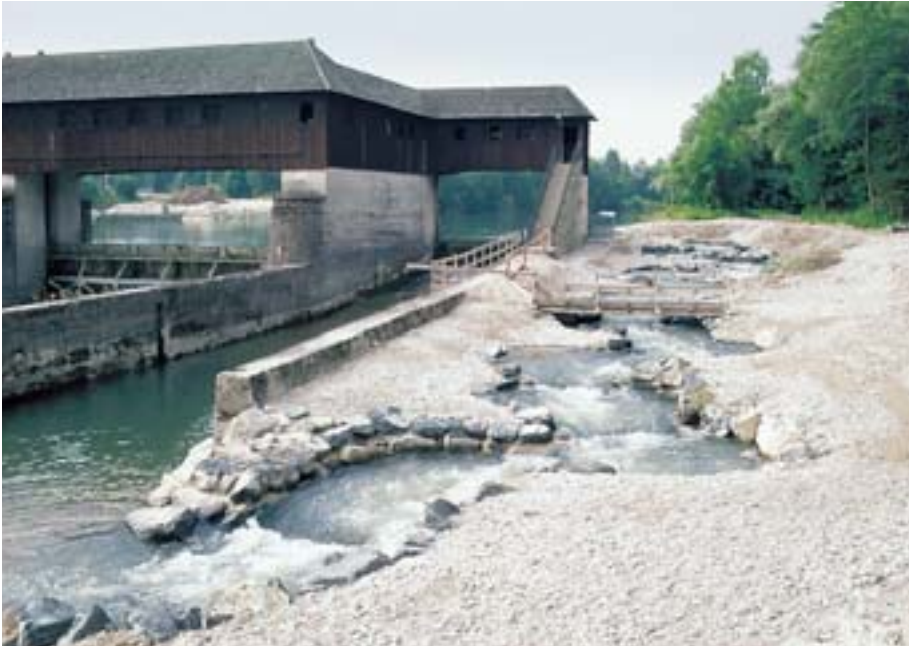
▲ Wasserkraftanlagen sind Sperren im Fluss. Fischtreppen und Umgehungsbäche sorgen dafür, dass Fische und andere Wasserorganismen sie umgehen können.
