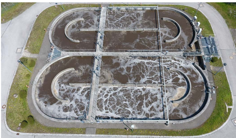
Abb. 15: Belebungsbecken der Kläranlage Weilheim in Oberbayern
