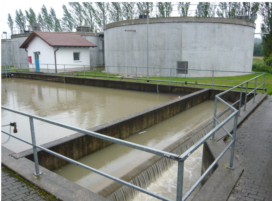
Abb. 8: Regenüberlaufbecken in der Mischwasser- kanalisation
