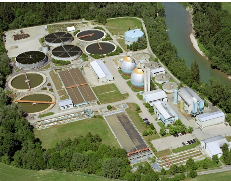
Kläranlage im Auenbereich
