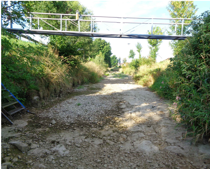
Abb. 54: Messsteg mit Radarsensor über dem trockengefallenen Flussbett der Kirnach am Pegel Unterhingau am 09.08.2018
