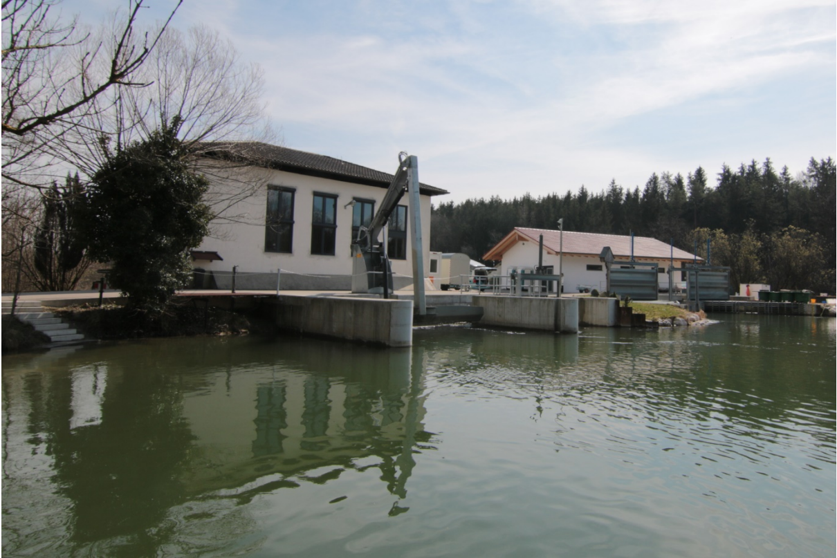
Abb. 1: Kraftwerksanlage am Standort Höllthal an der Alz während der Untersuchungen durch den Lehrstuhl für Aquatische Systembiologie der TU München im Herbst 2018. Blick vom Oberwasser auf das konventionelle Kraftwerk mit Kaplan-Turbine (links) und das Kraftwerksgebäude mit den beiden Wasserkraftschnecken (rechts)
