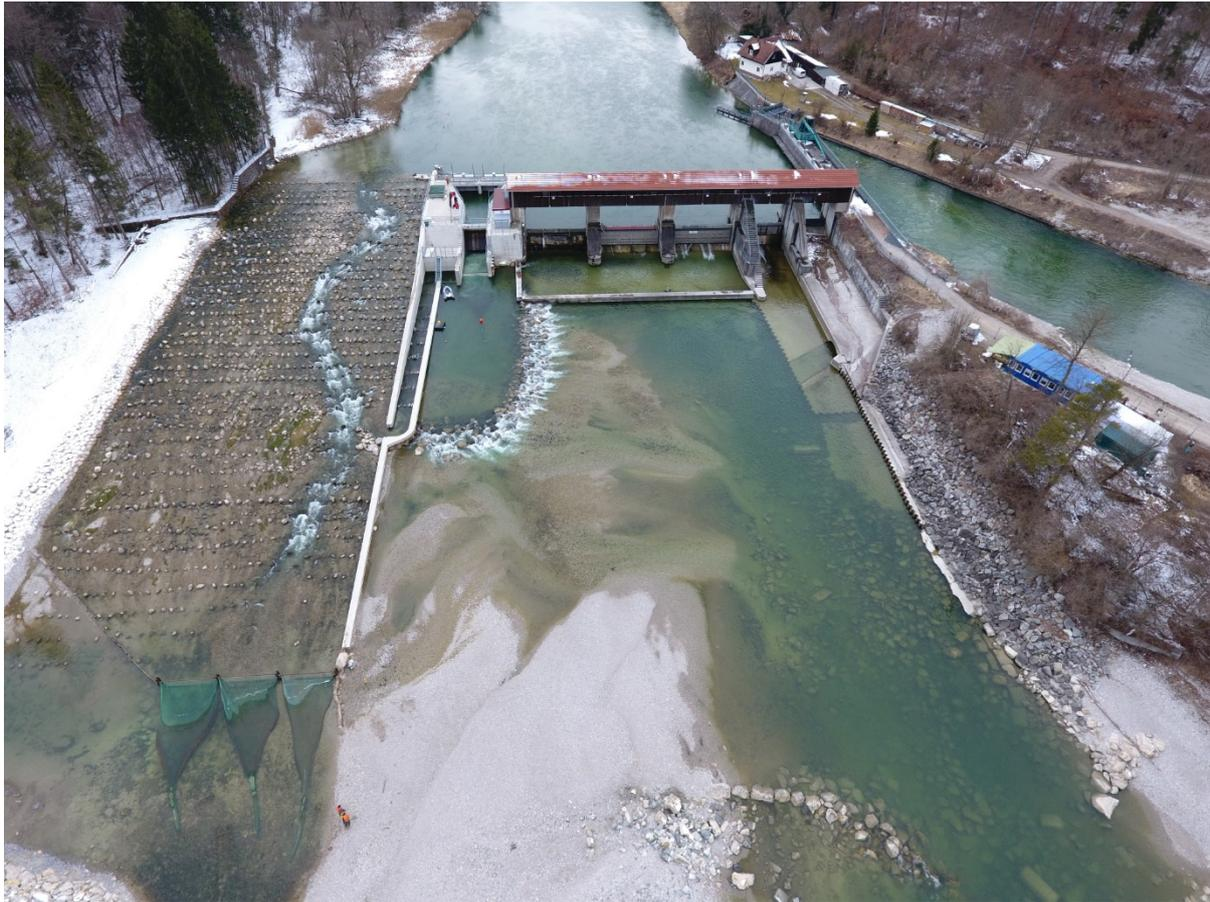
Abb. 1: Drohnenaufnahme des VLH-Kraftwerks am Standort Baierbrunn an der Isar während der Untersuchungen durch den Lehrstuhl für Aquatische Systembiologie im Jahr 2017. Blick vom Unterwasser auf die Wehranlage mit dem Kraftwerk und der rauhen Rampe
