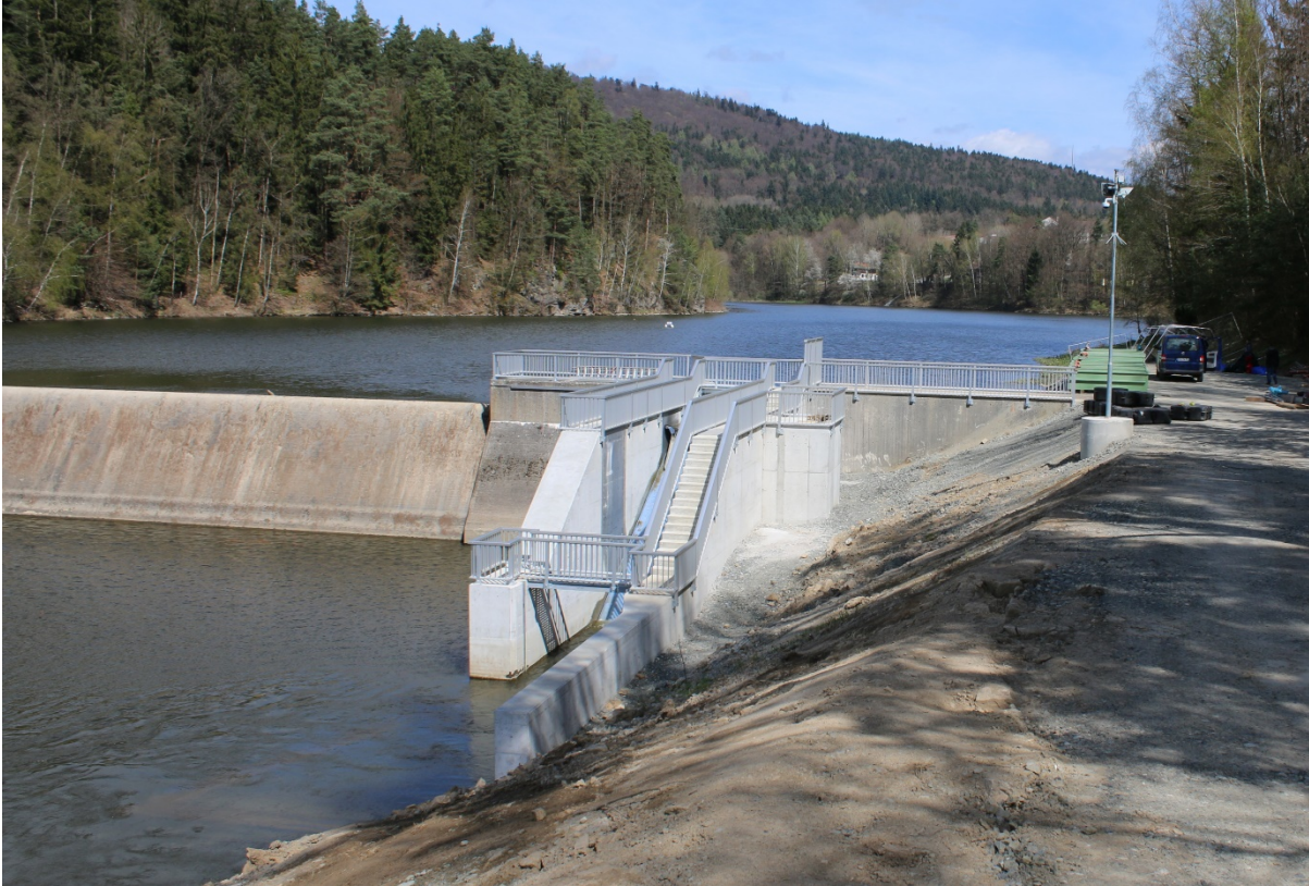
Abb. 1: Bewegliches Kraftwerk Eixendorf an der Schwarzach vor Beginn der Untersuchungen durch den Lehrstuhl für Aquatische Systembiologie der TU München im Frühjahr 2017. Blick vom Unterwasser auf die Wehranlage mit dem Kraftwerk
