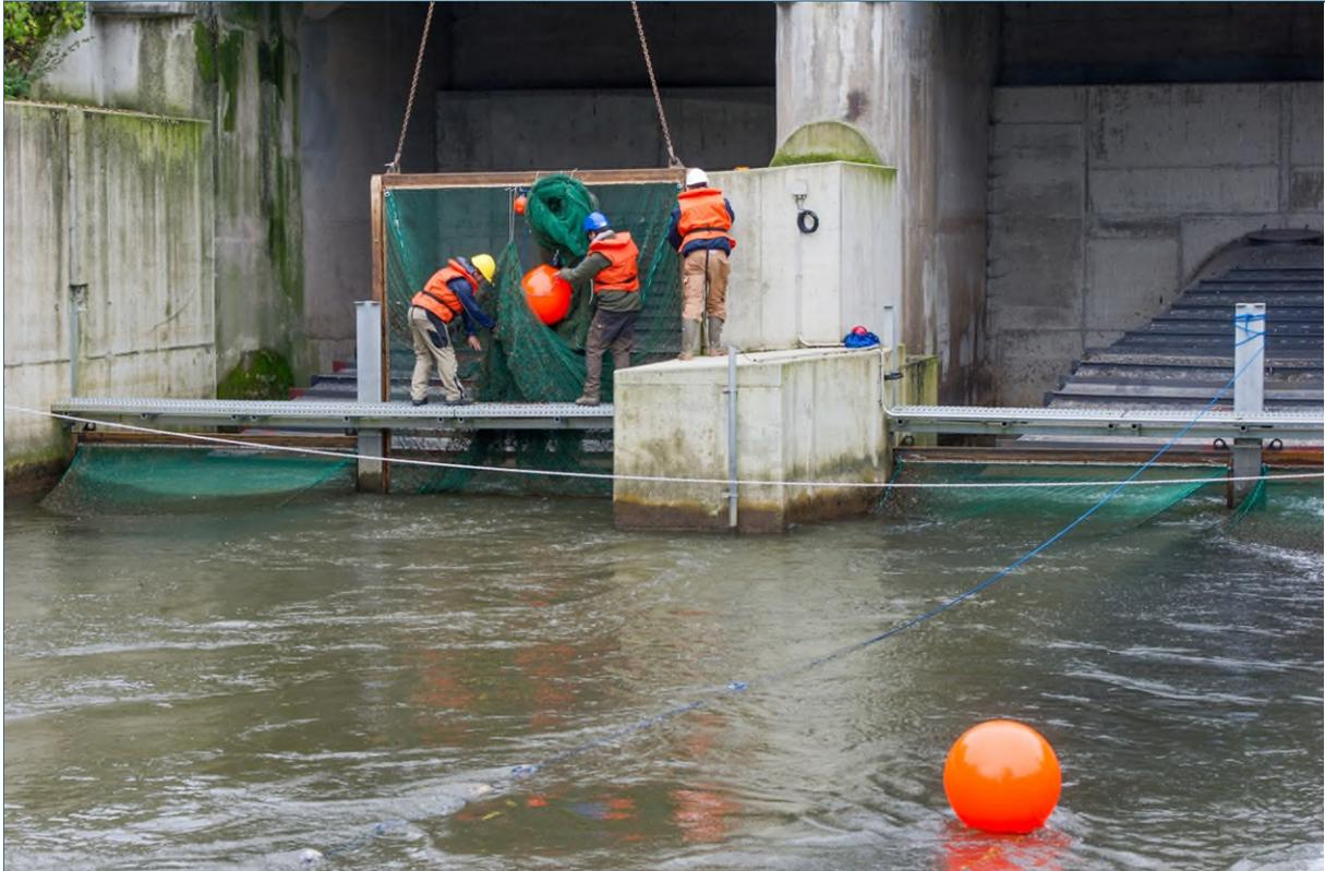
Abb. 9: Einheben eines Hamens mit Rahmen in die U-Profile der Revisionsverschlüsse unterhalb der Turbinen
