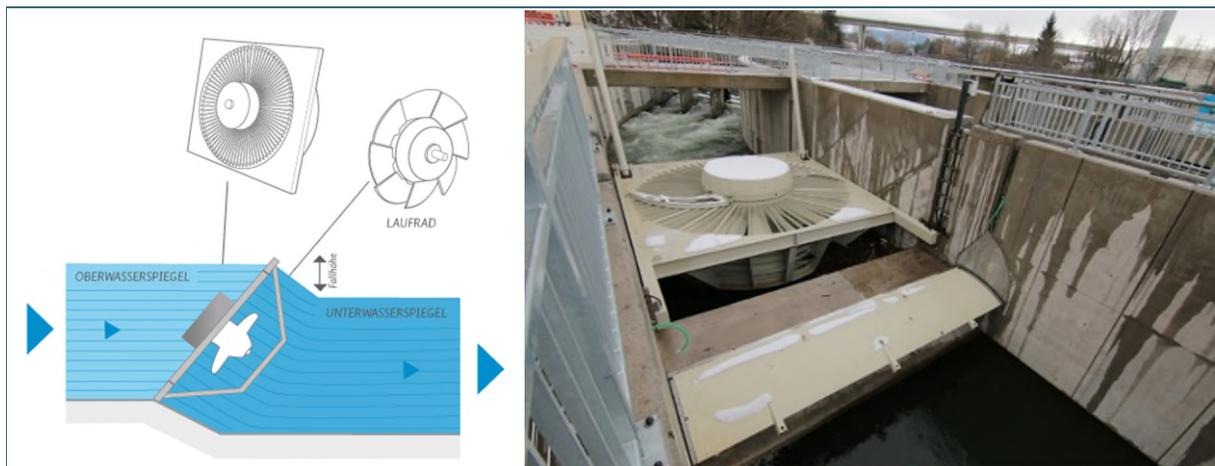
Abb. 2: Links: Schematische Darstellung einer VLH-Turbine im Fluss, Rechts: Foto der in Au an der Iller eingebauten VLH-Turbine bei abgesenktem Wasserstand
