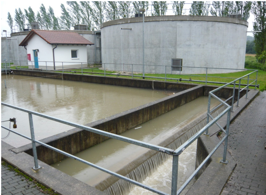
Abb. 8: Regenüberlaufbecken in der Mischwasser- kanalisation bei Stark- regen
