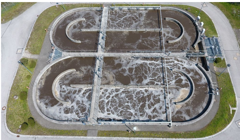
Abb. 15: Belebungsbecken der Kläranlage Weilheim in Oberbayern
