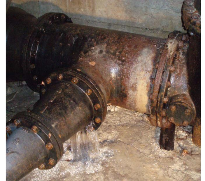
Durch Korrosion werden Leitungen schleichend zerstört.
