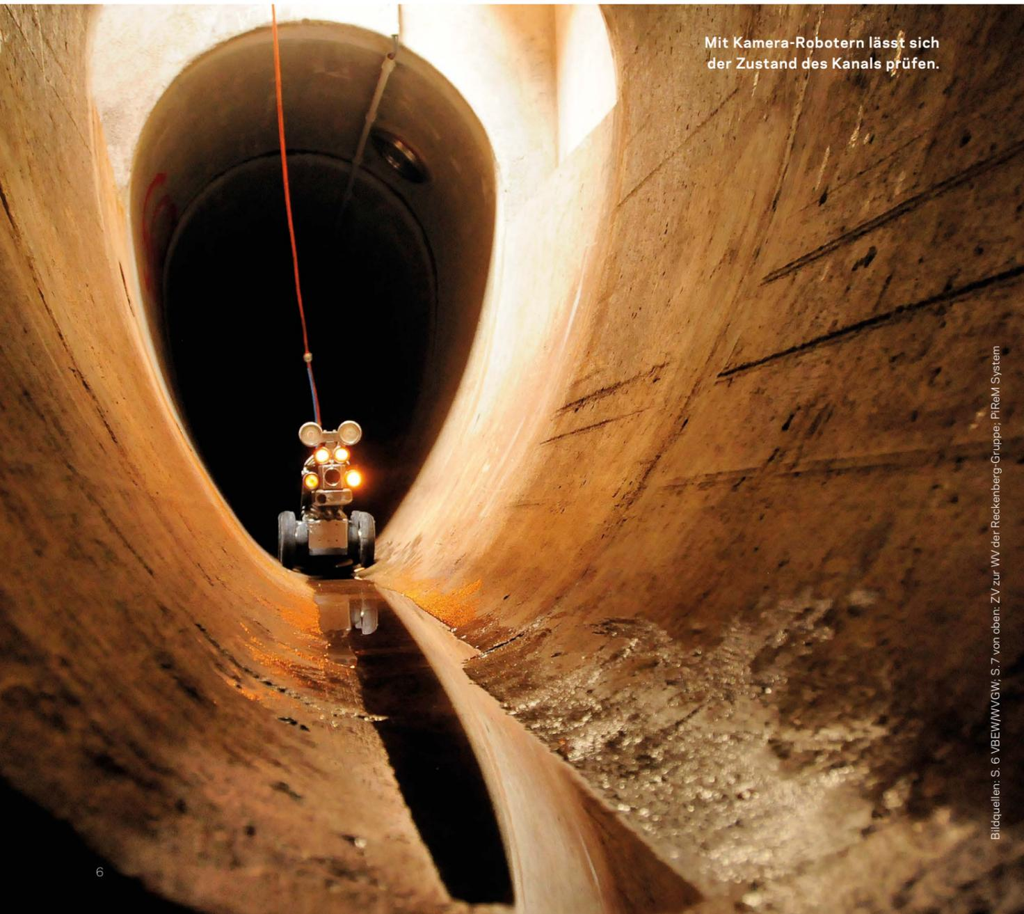
Mit Kamera-Robotern lässt sich der Zustand des Kanals prüfen.
