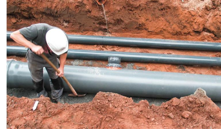
Für Sanierungen in offener Bauweise, wird der Boden aufgedigelt.
