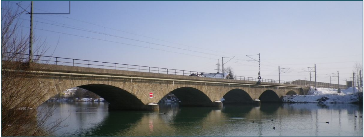
Abb. 63: Foto einer Bogenbrücke
