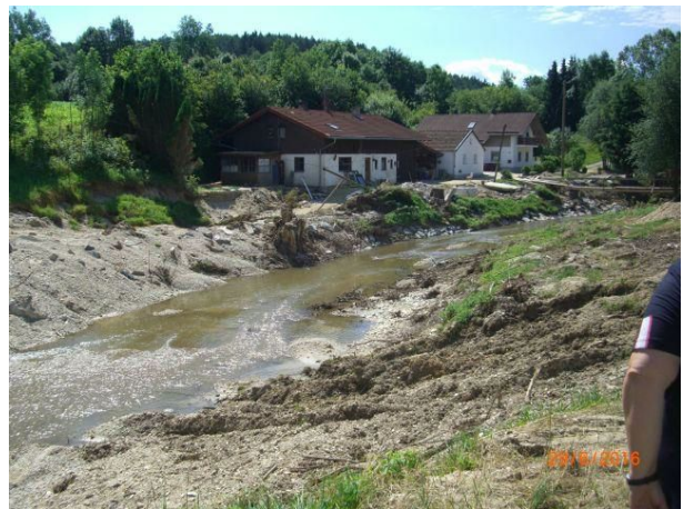
Abb. 24: Die selbe Stelle mit völlig ausgeräumtem Bachbett, 28 Tage nach der Sturzflut
