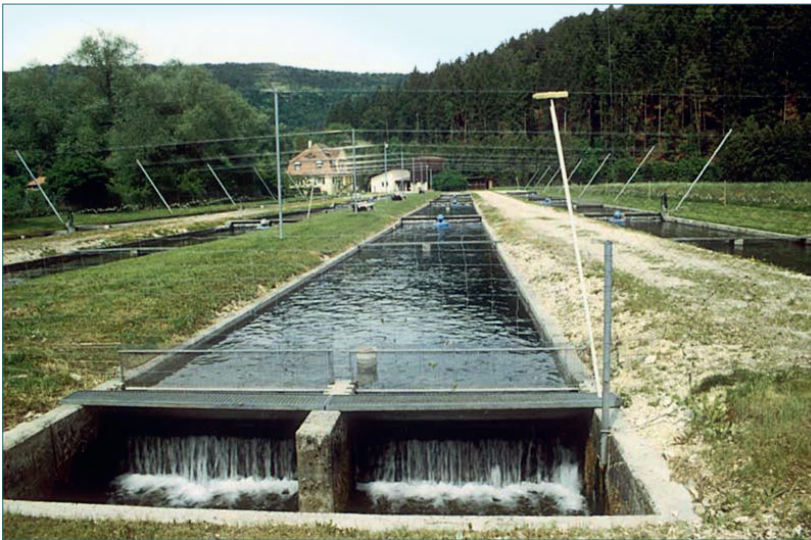
Abb. 110: Fließkanal zur Forellenhaltung [134]
