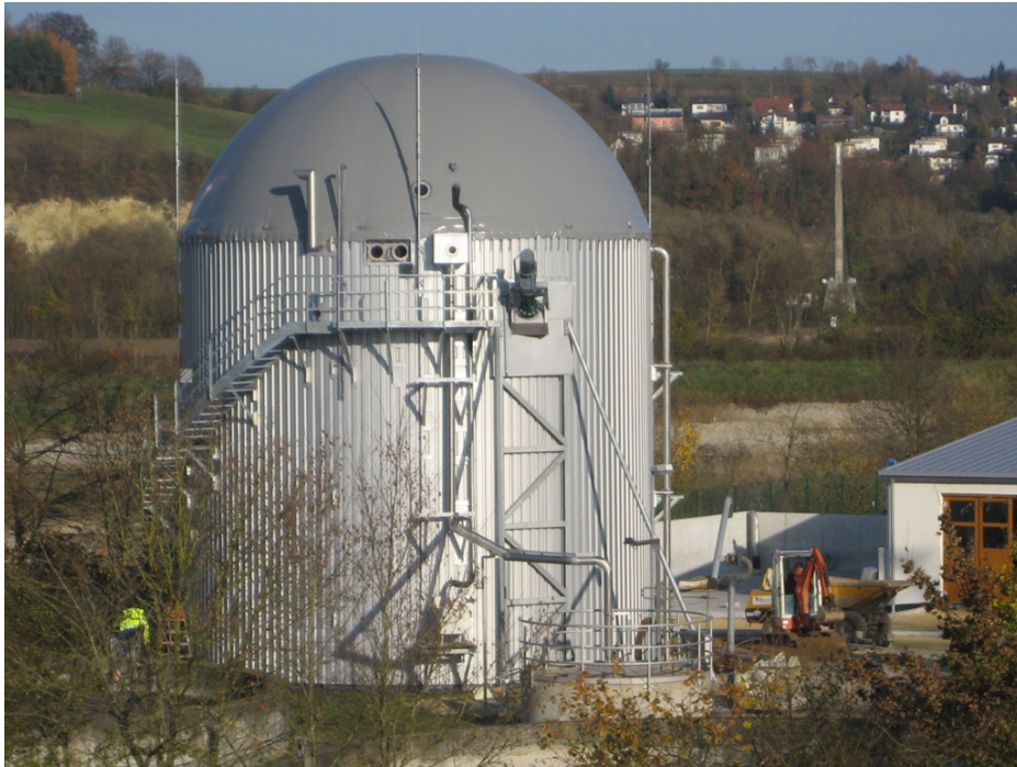
Abb. 11: Faulbehälter mit integriertem Gasspeicher in Bad Abbach
