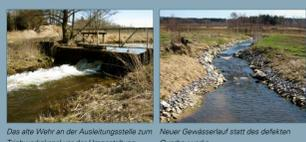
Das alte Wehr an der Ausleitungsstelle zum Triebwerkskanal vor der Umgestaltung. Neuer Gewässerlauf statt des defekten Quertauers.
