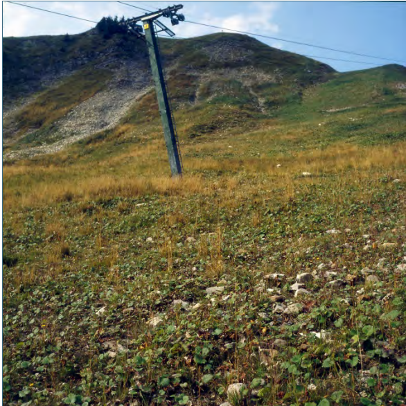
Abb. 39: Bei der Planierung von Skipisten wird der humusreiche Oberboden abgeschoben; zurückbleibt ein stark verdichteter Rohboden, auf dem sich Rohbodenpioniere wie der Huflattich sich ansiedeln: Oberflächenabfluss über 75 %
