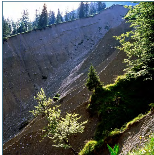
Abb. 5: Feilenanbruch: Oberflächenabfluss über 75 %
