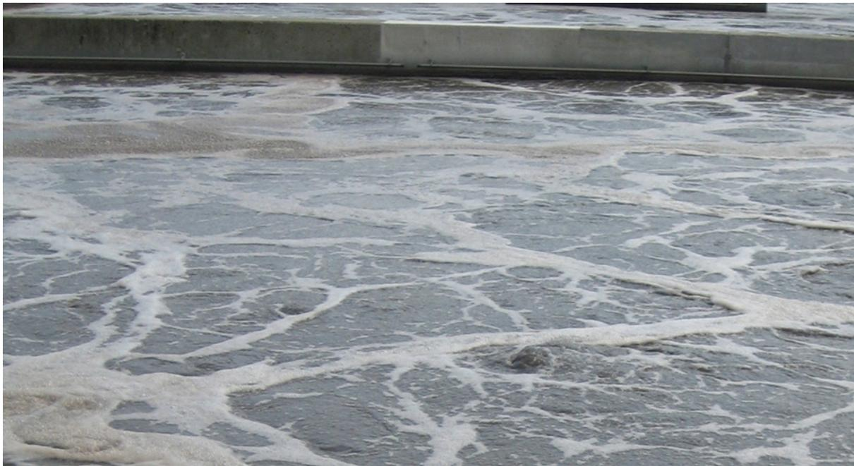
Abb. 14: Belebungsbecken mit feinblasiger Belüftung
