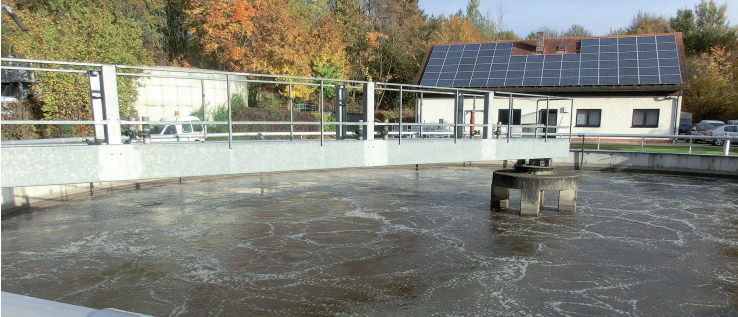
Abb. 1: Kläranlage mit Photovoltaikanlage auf dem Betriebsgebäude
