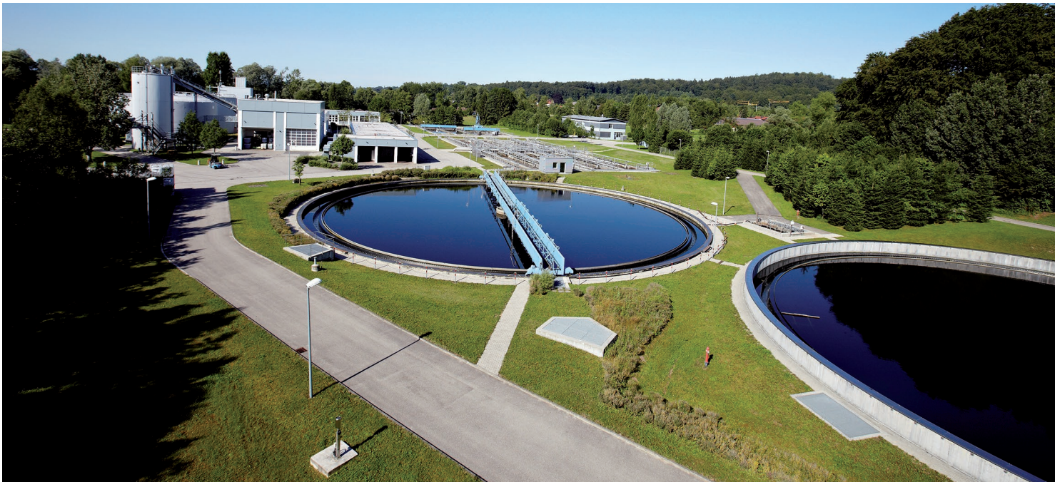
Abb. 26: Die energetisch optimierte Kläranlage Starnberger See
