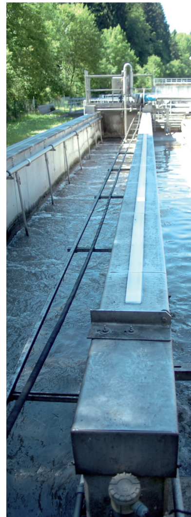
Abb. 28: Belüfteter Sandfang
