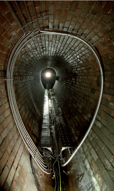
Abb. 7: Edelstahl-Wärmetauscher auf der Kanalsohle (links)
