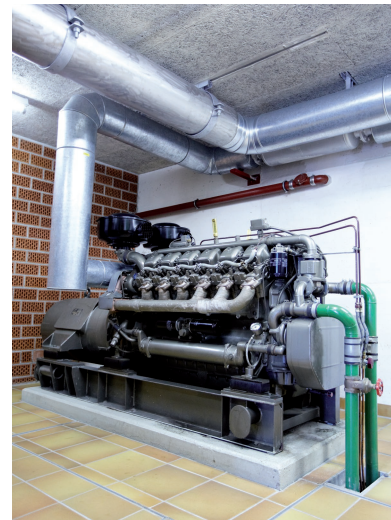
Abb. 35: Blockheizkraftwerk
