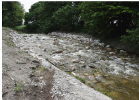
Nachher – Durch Auflösung des Querbauwerks an der Mindel durch eine Sohlgleite werden wieder Wanderungen von Fischen und Kleintieren ermöglicht.
