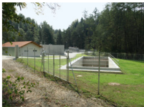
Die Kläranlage Lalling entzieht dem Abwasser gezielt Nährstoffe.
