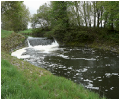
Vorher – Ein für Wassertiere unüberwindbarer Absturz an der Mindel.
