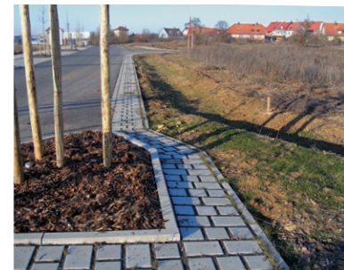
Offene oberirdische Regenwasserableitung
