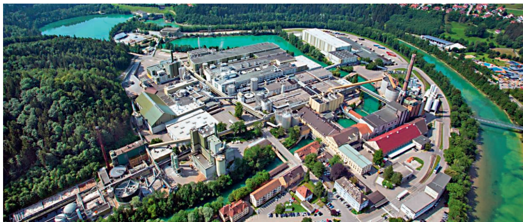
Papierfabrik der UPM GmbH, Werk Schongau
