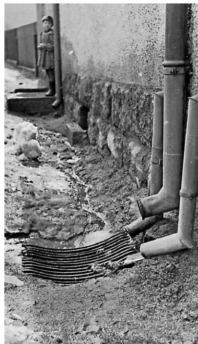
Bild links: Straßengraben zur Ableitung von Abwasser und Regenwasser
