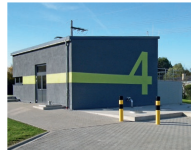
4. Reinigungsstufe Kläranlage Weißenburg
