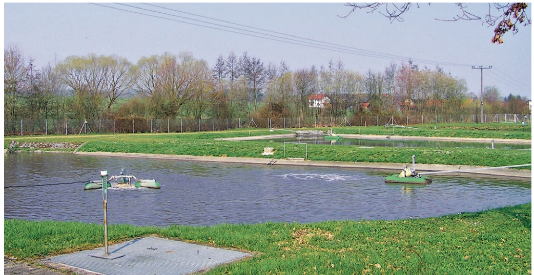
Belüftete Abwasserteichanlage in Bayerbach bei Ergoldsbach (2.500 EW Ausbaugröße)
