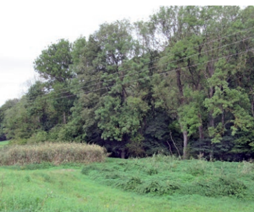
Pflanzenkläranlage Thann (180 EW Ausbaugröße)
