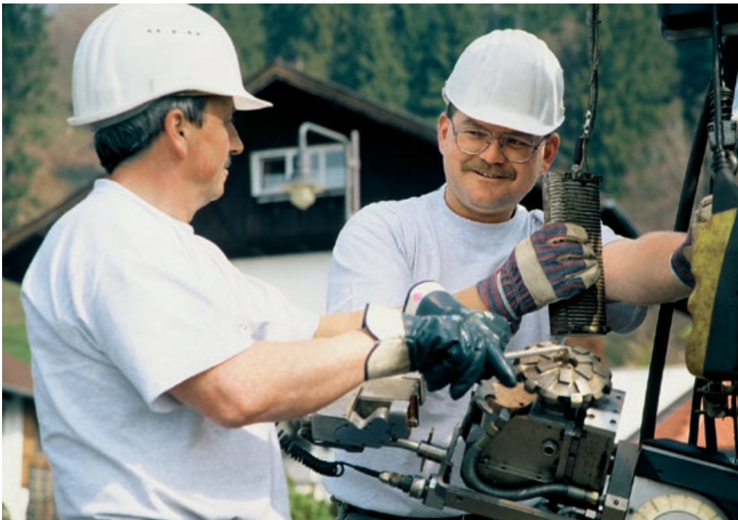
Abb. 12: Fräsroboter vor dem Einsatz im Kanal
