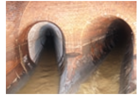
Abb. 2: Kanäle sind häufig der größte Vermögenswert einer Gemeinde.
