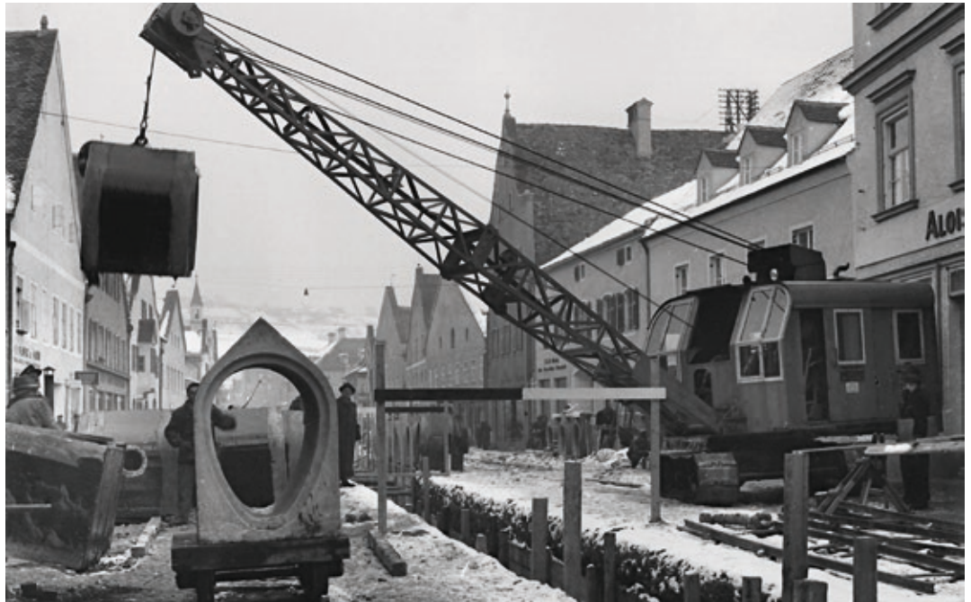
Abb. 5: Kanalbau in Kelheim 1952
