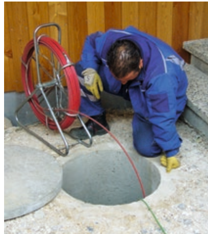
Abb. 30 und 31: Tragbare Schiebekamera zur Inspektion von GEA
