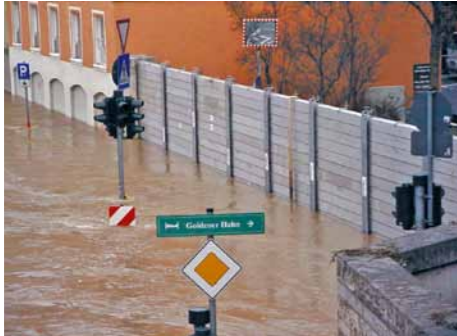
Mobile Hochwasserschutzzelemente verhindern die Überflutung der Würzburger Innenstadt, Januar 2003.
