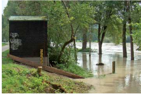
Typisches Pegelhäuschen (an der Isar, bei Hochwasser)
