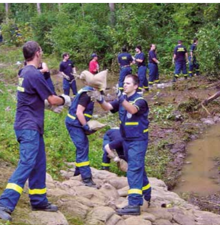
Augusthochwasser 2005: Einsatzkräfte – hier das Technische Hilfswerk – sichern einen Deich.
