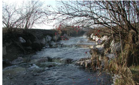
Davor – Danach: Der Absturz wurde mittels einer rauen Rampe biologisch durchgängig gestaltet. (Fotos: T. Hofmann)
