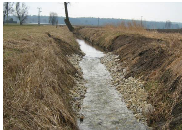
Absturzbau Nr. 1 von 6. Danach (Foto: M. Burkhart)
