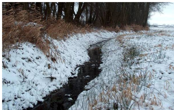
Buchbach, oberstrom. Das Geschiebe aus dem Frankenwald führt zur Aufsattelung des Baches. (Foto: NN)
