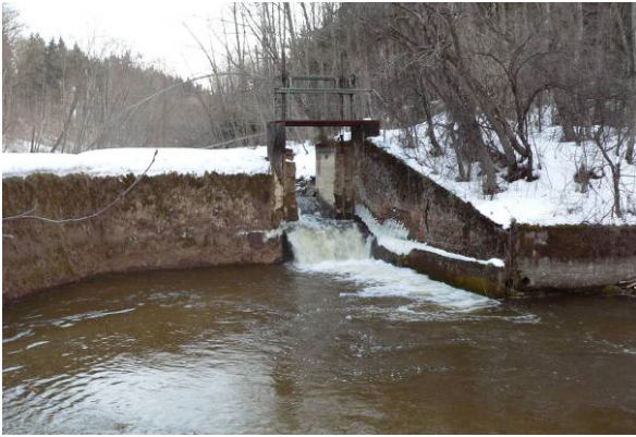
Altes, biologisch undurchgängiges und funktionslos gewordenes Wehr. (Foto: J. Schnell)
