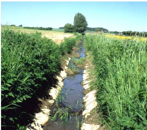
Betonierter Graben zur Sulz vor der Renaturierung. (Foto: LPV NM i.d. OPf.)
