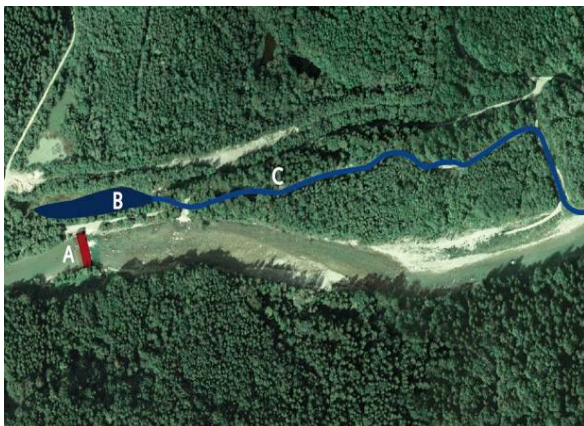
Legende: A=Wehr, B=Altwasser, C=neues Umlaufgerinne. (Am Ende von B befand sich der alte Mönch bzw. der unüberwindbare Auslauf des Altwassers in die Ammer). (Foto: M. v. Siemens)
