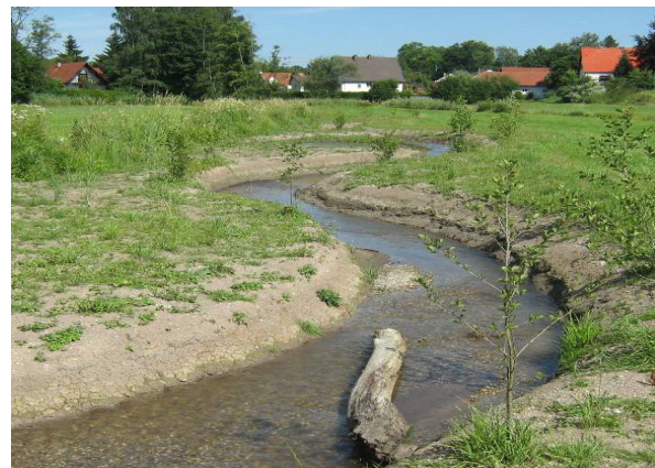
Bauzustand / Danach: Aus dem begradigten Nöbach wird sich ein naturnaher Bach mit einem Ufergehölzsaum (Initialpflanzung) und angrenzenden Feuchtbiotopen entwickeln können. Der Hochwasserrückhalt in der Fläche wird verbessert. (Fotos: M. Burkhart)
