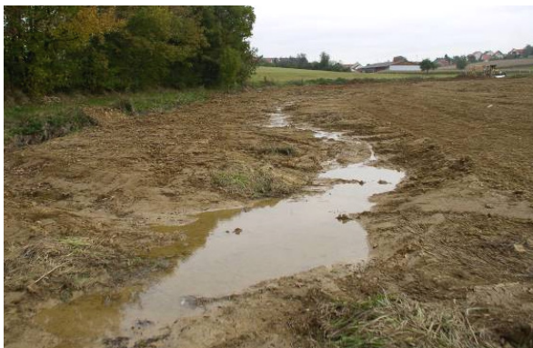
Renaturierung des Grundbaches im Herbst 2004. Abgesteckt wird nur die Bachtrasse. Die Hauptarbeit liegt in der Hand des versierten Baggerfahrers. Eine gute Einweisung und Betreuung vor Ort ist Voraussetzung. Die abschließende Modellierung übernimmt der Grundbach. (Fotos: N. Schneider)
