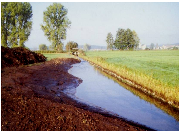
A Grabenaufweitung am Schutter-Flutkanal. (Foto: M. Burkhart)
