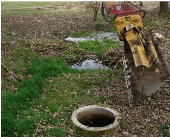
Quellfassung vorher. Bagger setzt zum Herausheben der Betonringe an (Foto: J. Römheld).
