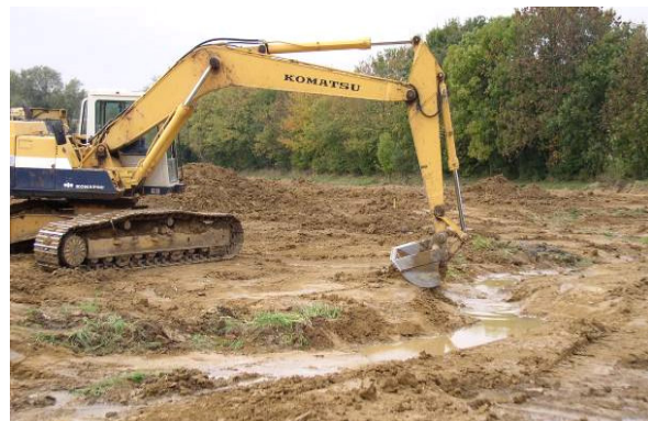
Renaturierung des Grundbaches im Herbst 2004. Abgesteckt wird nur die Bachtrasse. Die Hauptarbeit liegt in der Hand des versierten Baggerfahrers. Eine gute Einweisung und Betreuung vor Ort ist Voraussetzung. Die abschließende Modellierung übernimmt der Grundbach. (Fotos: N. Schneider)
