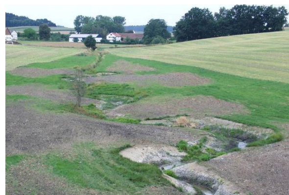
Nach der Renaturierung: Blick nach Oberstrom. (Foto: T. Atzenhofer)
