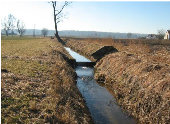
Absturzbau Nr. 1 von 6. Davor (Foto: M. Burkhart)
