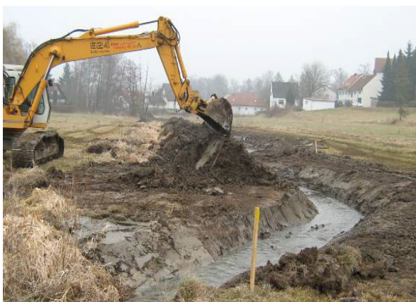
Bauzustand / Danach: Aus dem begradigten Nöbach wird sich ein naturnaher Bach mit einem Ufergehölzsaum (Initialpflanzung) und angrenzenden Feuchtbiotopen entwickeln können. Der Hochwasserrückhalt in der Fläche wird verbessert. (Fotos: M. Burkhart)
