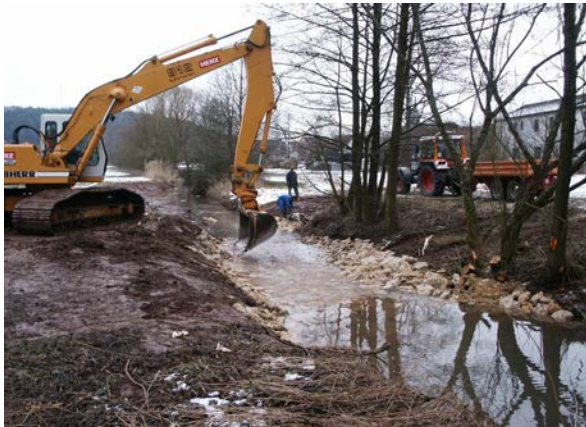
Einbau der rauen Rampe. Der Bagger drückt die großen Steine ein. (Foto: D. Hofmann)
