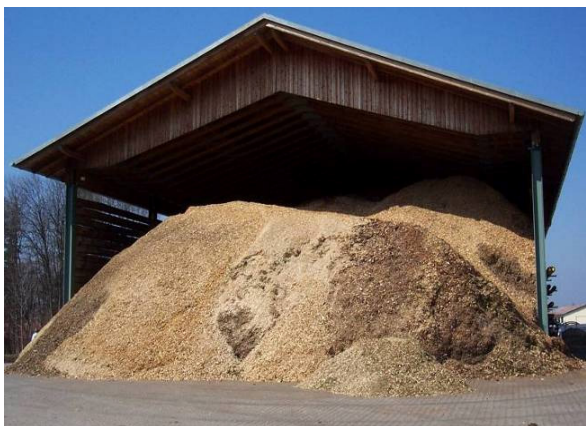
Silo für Biomasse Dorfheizung. (Foto: R. Schoberer)
