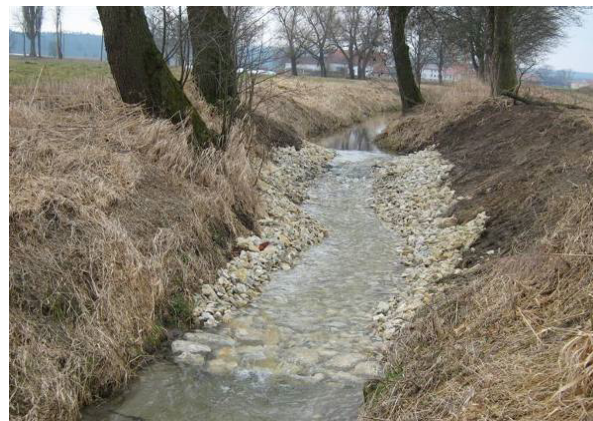
Absturzbau Nr. 2 von 6. Danach (Foto: M. Burkhart)
