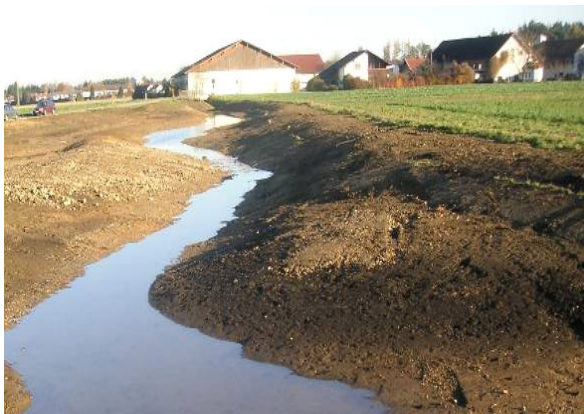
BA 02 unmittelbar nach der Renaturierung: Erstellt wurde nur das Rohplanum. (Foto: R. Schoberer)
