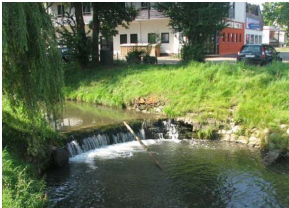
Vorher: Ein ca. 80 cm hoher Absturz aus Spundwänden und Wasserbausteinen. (Foto: A. Röder)
