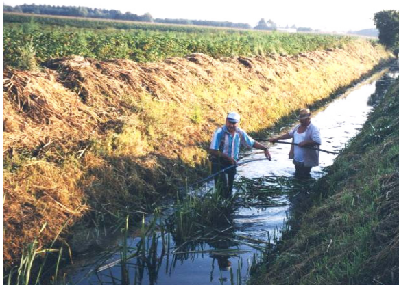
Grabenunterhaltung bedeutet auch heute noch häufig zeitaufwendige und anstrengende Handarbeit. (Foto: M. Burkhart)
