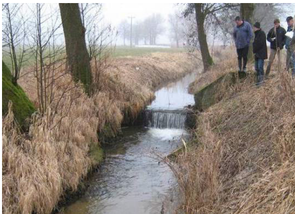
Absturzbau Nr. 2 von 6. Davor (Foto: M. Burkhart)
