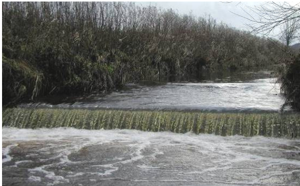
Davor – Danach: Der Absturz wurde mittels einer rauen Rampe biologisch durchgängig gestaltet. (Fotos: T. Hofmann)
