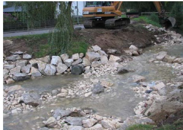
Nachher: Raue Rampe mit Leitströmung (Riegelhöhe 15 cm) und strömungsabseitigen Ruhezeiten. In Bildmitte: Auslauf Mischwasserentlastungskanal. (Foto: A. Röder)
