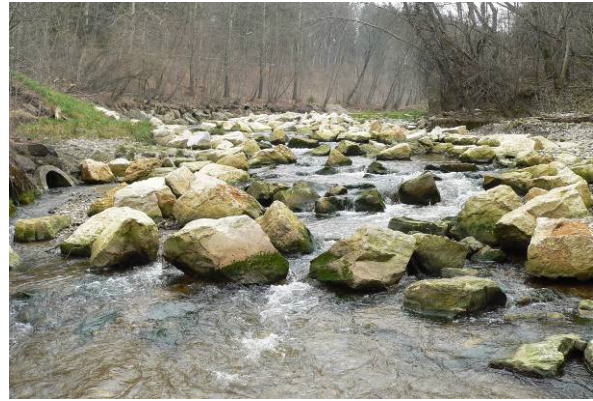
Biologisch durchgängige Sohlrampe. Aufgrund der Gewässerdynamik mit massiven Wasserbausteinen ausgeführt. (Foto: J. Schnell)
