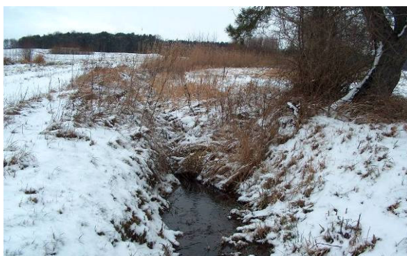
Blick auf den nicht geräumten oberstromigen Teilbereich des Bachl-Grabens. (Foto: NN)
