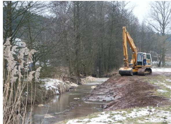
Die strukturreiche Ufer- und Sohlgestaltung mit Bermen wertet das Gewässer ökologisch auf. (Foto: D. Hofmann)
