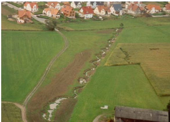
Renaturierungsstrecke nach der Baumaßnahme mit oberstrom angelegtem Sedimentfang. (Foto: LPV Weidenberg)
