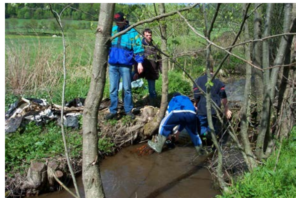
Hier wird gerade ein Abflusshindernis aus Schwemmgut und Siloplanen beseitigt. (Foto: F. Wurm)
