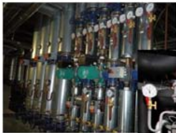
Heizungsverteiler
