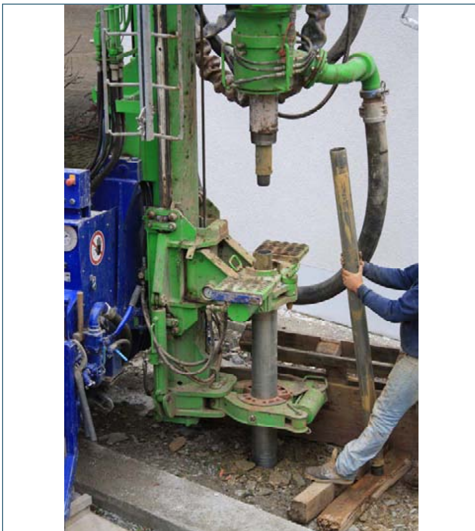
Abb. 1: Bohrung für eine Erdwärmesonde
