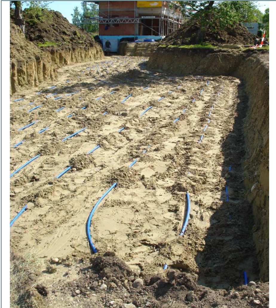
Abb. 2: Einbau eines Erdwärmekollektors (am/im©2008)
