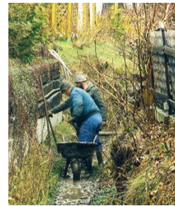
▲ Abfluss erhalten: Räumen und Freischneiden.
