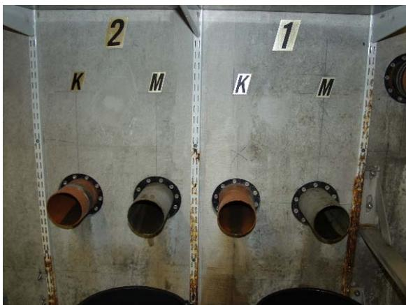
Bild 5: Dränabläufe nach Demontage der Probenteiler. Insbesondere bei SR 75 (rechtes Ablaufrohr) liegt Feinsediment auf der Sohle.
