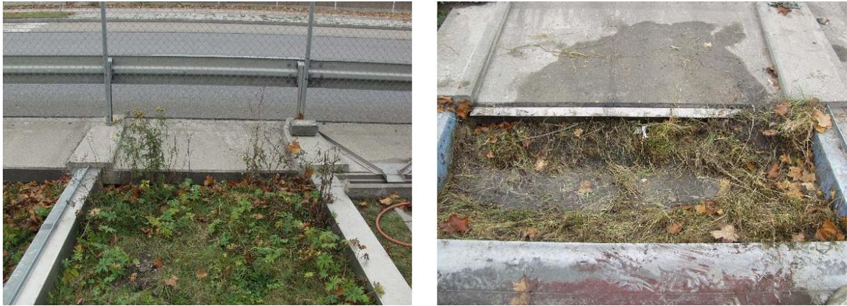
Bild 17: Der Zufluss am Tiefpunkt der Straße führt nicht nur im Bankett sondern auch auf den Feldern zu einer einseitigen Sedimentation. Linkes Bild: Feld SR 75. Auf der rechten Bildhälfte ist ein Sedimentkeil in Richtung des Straßengefälles zu erkennen. Rechtes Bild: Feld G 30. Die keilförmige Sedimentation in Richtung des Straßengefälles ist an der straßenseitigen Böschung und an der Grabensohle (rechts) zu erkennen.
