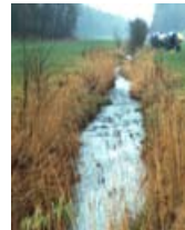
▲ Nachher: Naturnahe Sohlschwellen, Uferaufweitungen und Bewuchs bremsen das Hochwasser.
