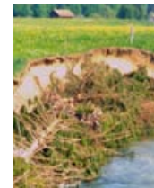
▲ Der Raubaum stabilisiert das Prallufer Temporär.
