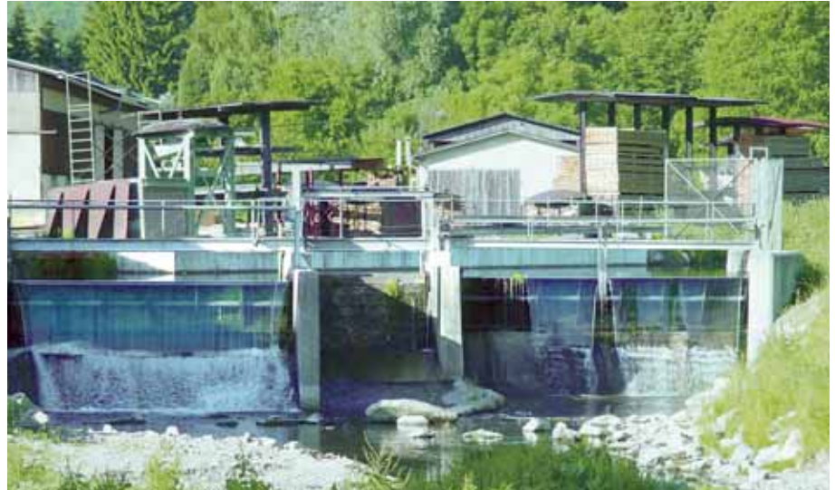
▼ Wasserkraftanlage an der Warmen Steinach oberhalb von Bayreuth.
