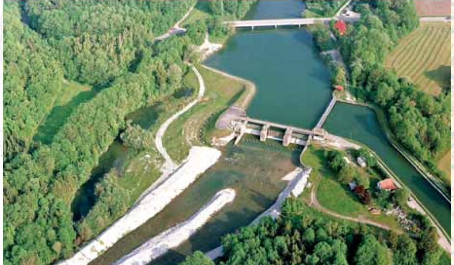
▲ Alz bei Tacherting - zum Erhalt der natürlichen Flussdynamik wird regelmäßig Geschiebe aus dem Staubereich in das Unterwasser der Wehranlage transportiert.
