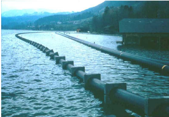
Abb.7: Verlegen der Ringleitung am Chiemsee
