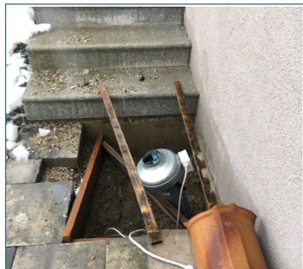
Abb. 5: provisorische Absaugung Drainage (Kaineder, Land OÖ.)
