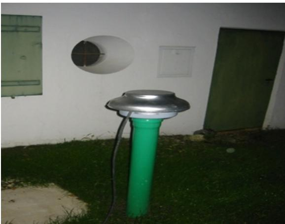
Spezialventilator, der die Luft herauszieht
