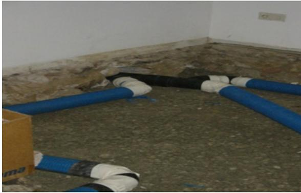
Verlegung einer Luftdrainage mit Abluft nach draußen durch einen Ventilator unterstützt
