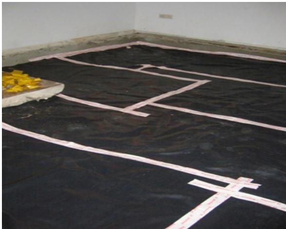
Folienaufbringung in zwei Laufrichtungen, zur Wand hin eingeputzt, verklebt und verschweißt
