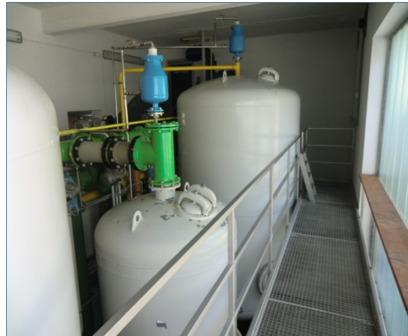
Abb. 21: geschlossene Filtertanks
