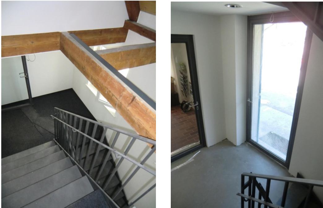
Abb. 39: Das von den einzelnen Stockwerken getrennte Treppenhaus.
