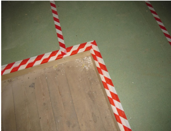
Abb. 17: Dämmung des Fußbodens auf dem Dachboden.
