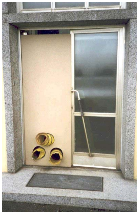
Abbildung 9.13: Flexible Ansaugrohre eines mobilen Belüftungssystems im Einsatz bei einer Behälterreinigung im Wasserversorgungsunternehmen Nr. 5332 (WS).
