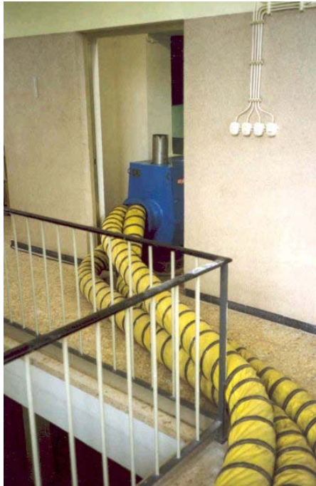
Abbildung 9.12: Mobiles Belüftungssystem im Einsatz bei einer Behälterreinigung im Wasserversorgungsunternehmen Nr. 5332 (WS).
