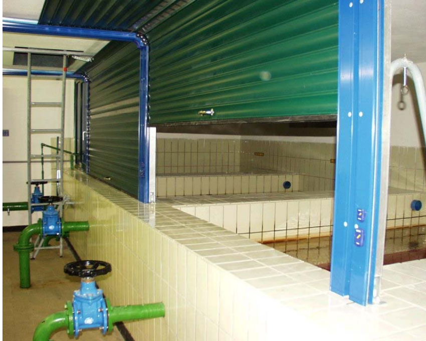
Abbildung 9.16: Eingebaues Rollo als Trennwand zu den Entsäuerungsbecken im Wasserversorgungsunternehmen Nr. 5425 (SB).
