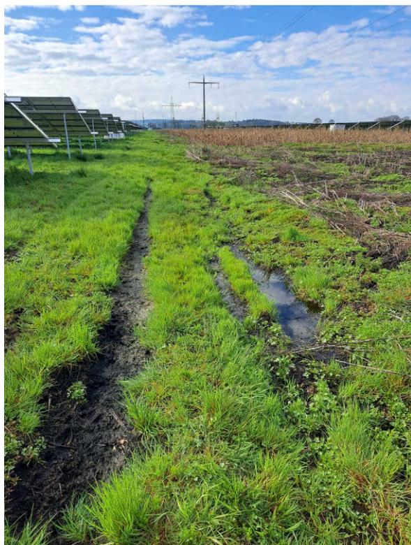
Abb. 33: Fahrspuren mit Pfützen zwischen PV-Modulen und angrenzender Brachfläche am 26.04.2023 im Nordteil der PV-Anlage
