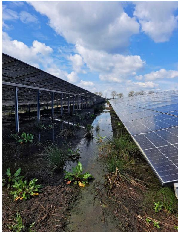
Abb. 31: Überstaute Modulflächen im Nordteil der PV-Anlage am 26.04.2023
