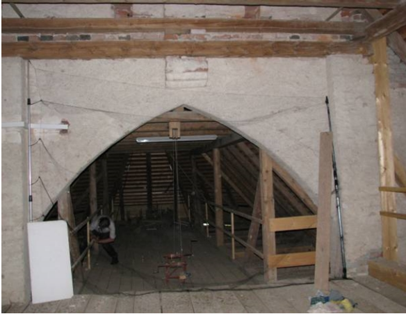
Abb. 4: Mit feinen Netzen wurden Durchgänge zwischen Turm, Schiff und Chor im Inneren des Dachraums abgespannt, um schwärmende Tiere fangen zu können (Aresing 2017).
