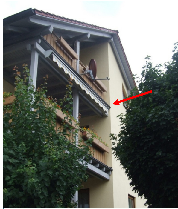
Abb. 41: Durch Telemetrie entdecktes Wochenstubenquartier in einem Spalt am Balkon (Pfeil) eines Mehrfamilienhauses in Hoheim.
